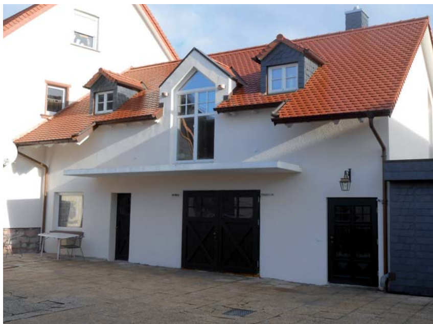
Bild 3.1: Anbau (umgenutzte Scheune).
