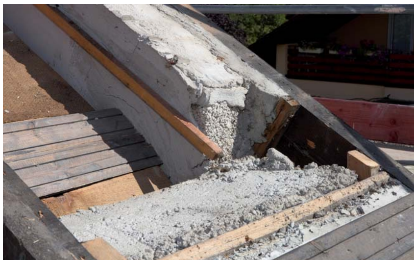
Bild 3.13: Mauerkrone: Die Vorbereitung des luftdichten Randanschlusses erfordert viel Zeit. [Foto: Moll/pro clima]
